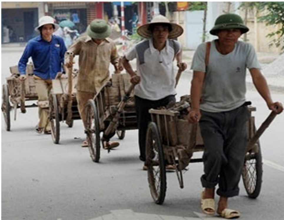
Ảnh 2: Người lao động di cư vận chuyển vật liệu xây dựng tại khu đô thị Yên Hòa Constrexim
