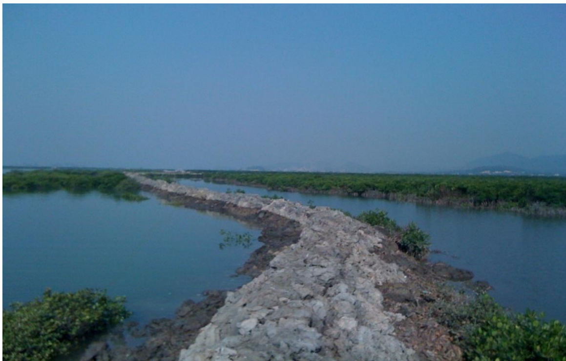
Hình 3.17 Đê bao rừng ngập mặn nuôi thủy sản khu vực Đại Yên
