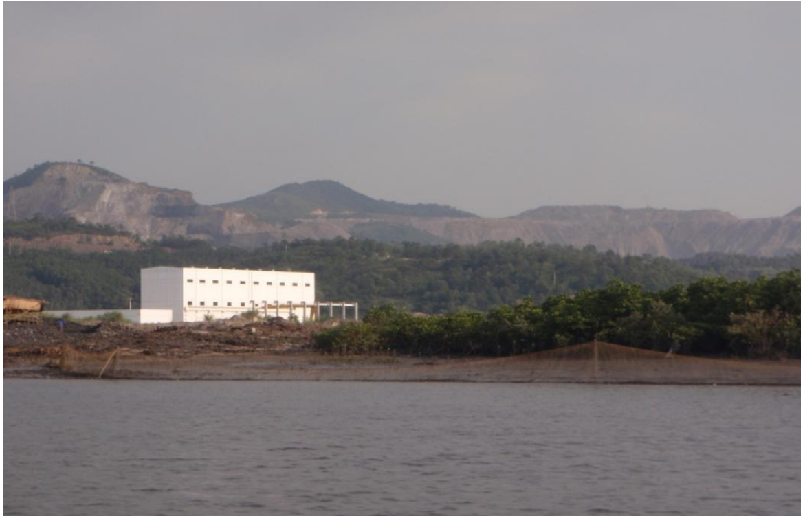
Hình 3.18 San lấp mặt bằng phá hủy rừng ngập mặn khu vực Bắc Cửa Lục
