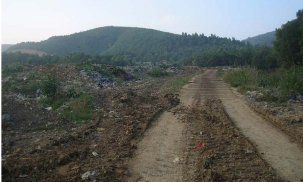
Hình 3.7: Hiện trạng bãi chôn lấp tại bãi rác Quang Hanh
