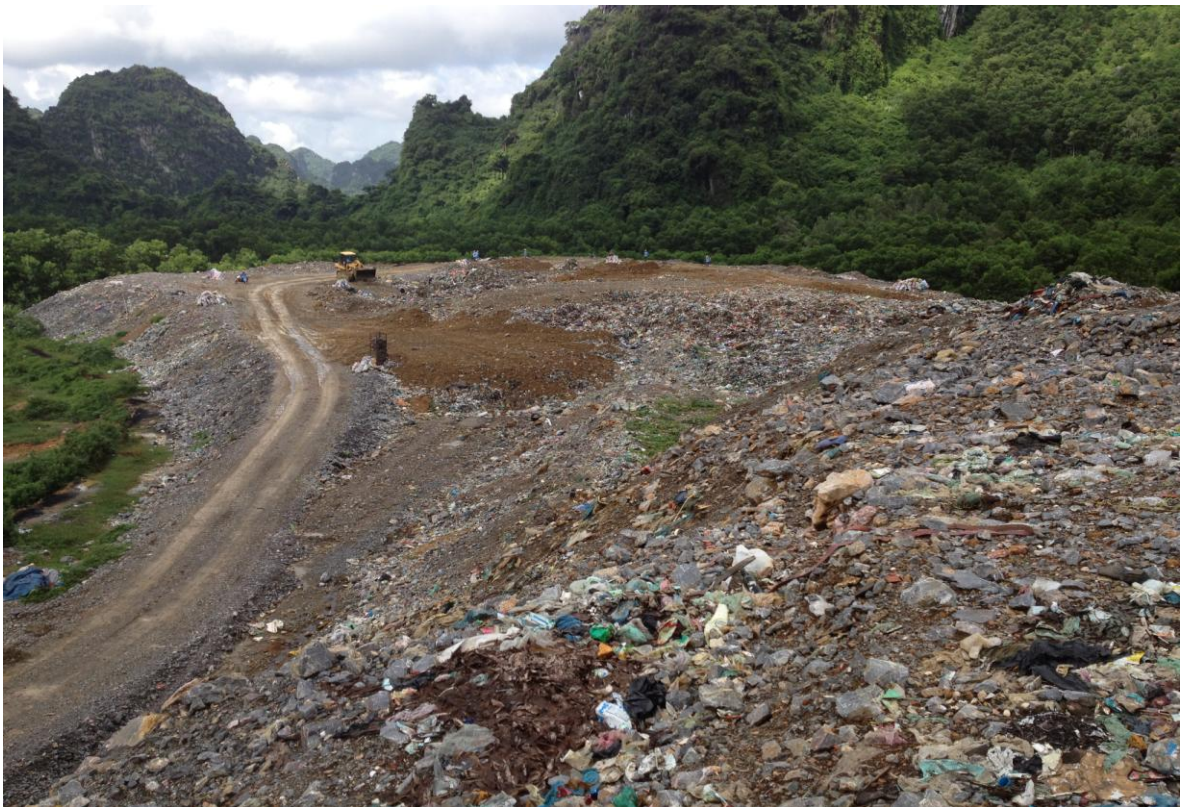
Hình 3.8: Hiện trạng khu xử lý nước rác tại bãi chôn lấp Quang Hanh
