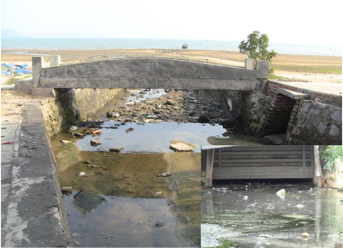
Cống gom nước thải bị hỏng – Nước thải nhà hàng, khách sạn khu vực Bãi Cháy đang đổ trực tiếp ra vịnh năm 2013
