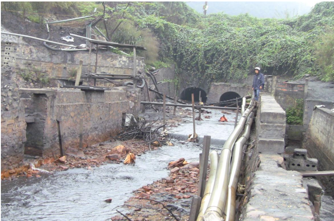
Nước thải mỏ than Cọc 6 không qua hệ thống xử lý đổ trực tiếp vào mương thoát ra biển năm 2013
