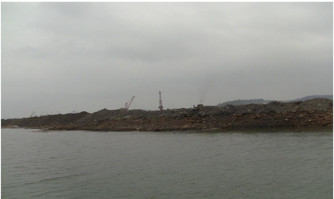
San lấp mặt bằng không có kè vây tại khu đô thị Cao Xanh – Hà Khánh năm 2013
