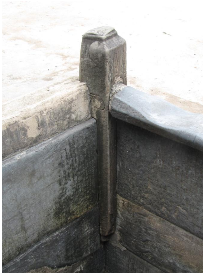
Bản ảnh 85: Kỹ thuật gắn kết các thanh đá giếng làng Mỹ Lợi [Nguồn: Tác giả]
