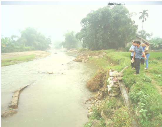
Hình 3.9: Một đoàn suối Ngòi Đường bị sạt lở và hư hỏng kè
