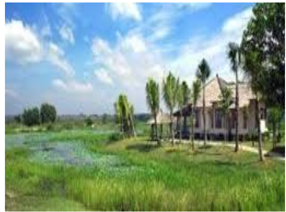
Hình 1.4: Khu bảo tồn đất ngập nước và khu nghỉ dưỡng đã xây dựng trên nền khu mỏ thiếc
