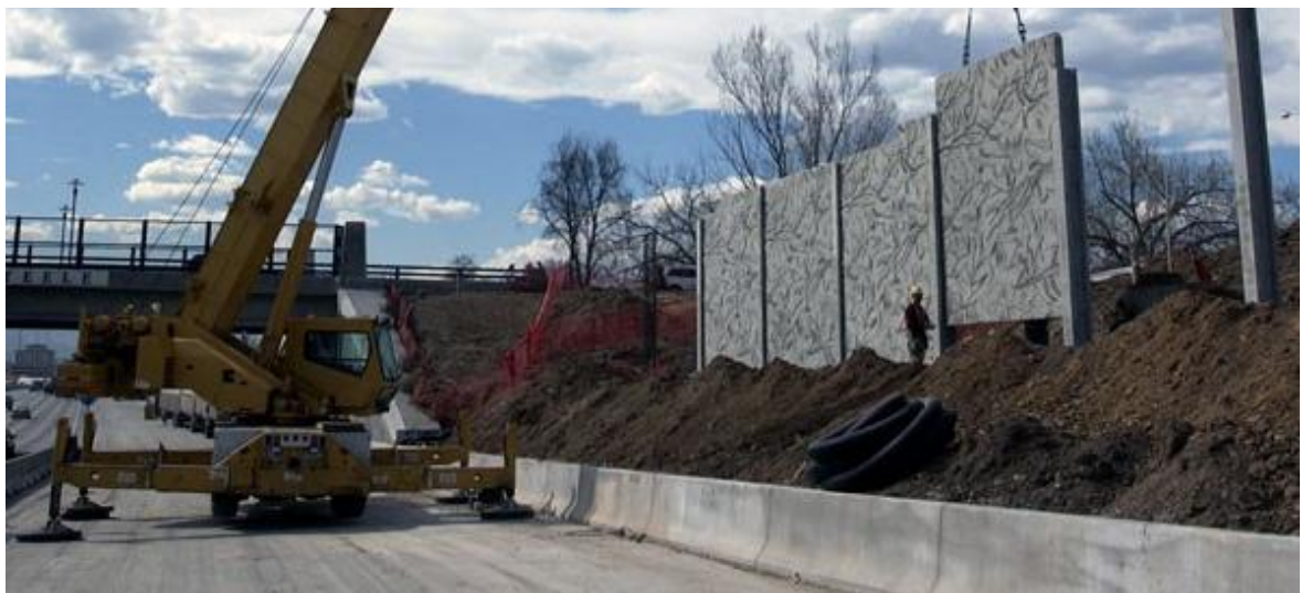
Hình 3.11. Thi công lắp đặt tường chống ồn bê tông
